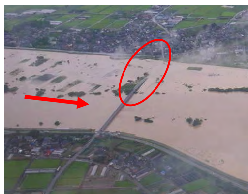
④出水時の庄瀬橋 H23.7.30撮影
